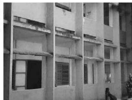
Pavillon d'hospitalisation : les hommes à l'étage, les femmes et les enfants au rez de chaussée.
