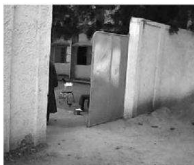
Porte d'entrée du service de psychiatrie à l'intérieur de l'hôpital national de Niamey.
