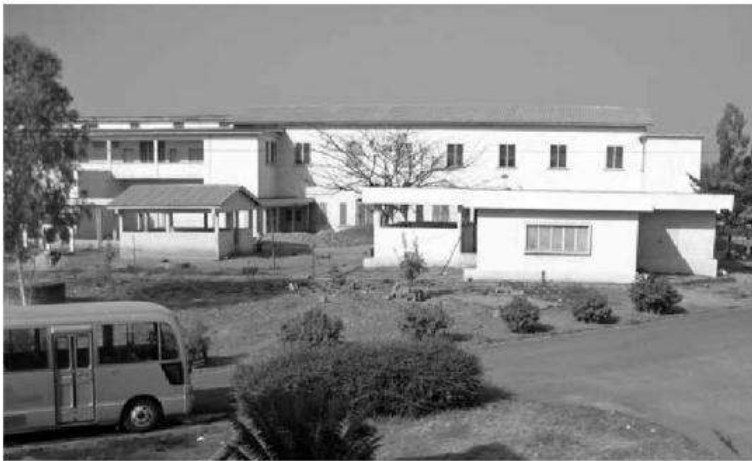
Vue du Centre Hospitalier de Parakou (2008).
