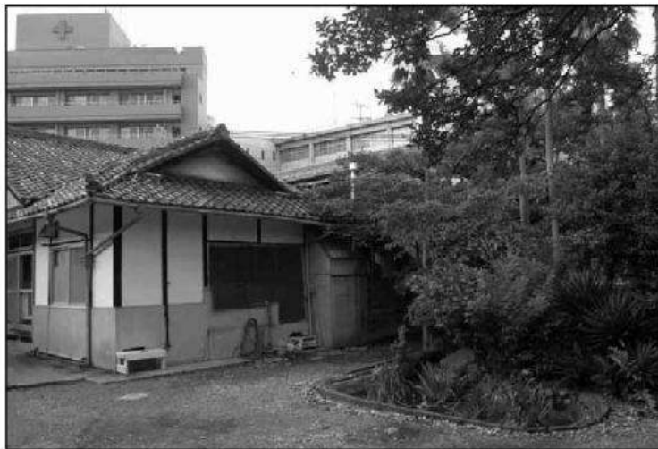
Au premier plan, la petite structure architecturale de l'Hôpital Sansai. Au second plan, le grand hôpital moderne. Kyoto 2013.
