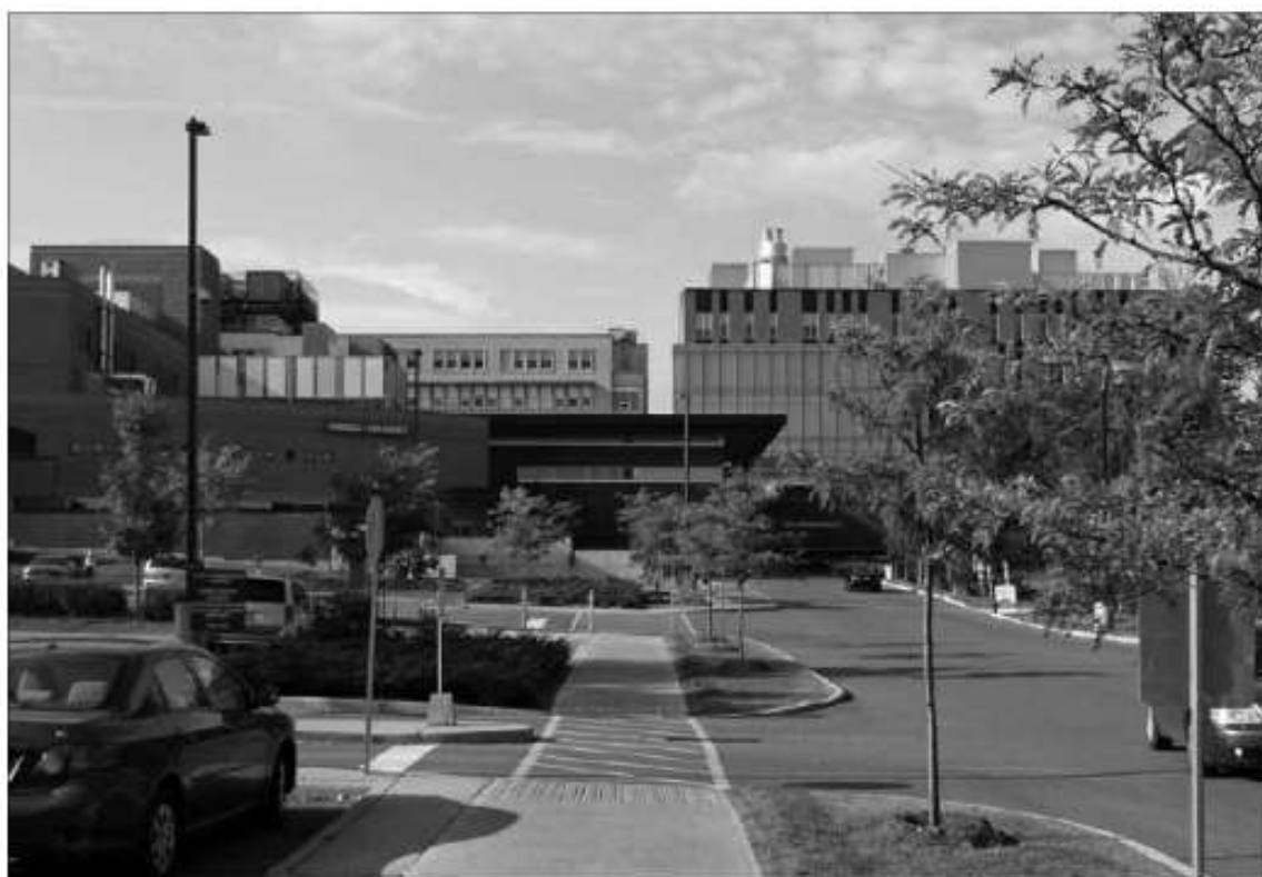
Entrée de l'Hôpital Montfort. Photo Psy Cause, septembre 2013.
