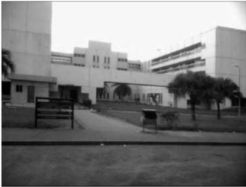
Vue du CHU de Yopougon (Abidjan). Photo de l'auteur.
