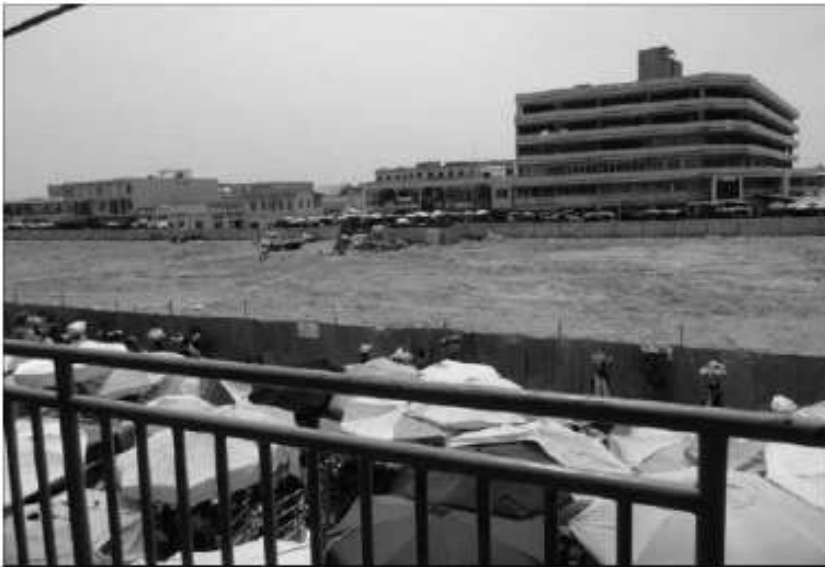
Grand Marché de Lomé totalement détruit. Photo de l'auteur.
