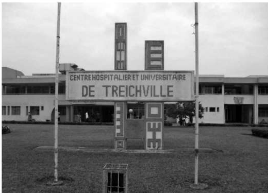
Bâtiment des urgences du CHU de Treichville (situé à l'entrée du CHU). Photo de l'auteur.
